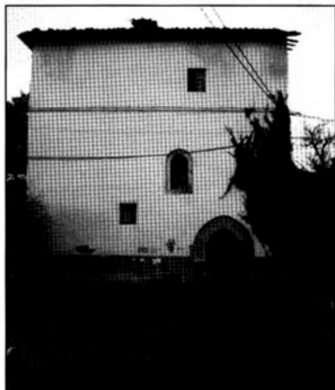
Casa Torre nº 27. Con sus 2 puertas ojivales a distintas alturas. El raseo impide ver otros elementos.
