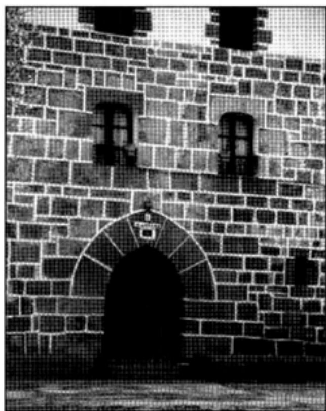
Caserío Arana, nº 52. Fachada principal, con su acceso de arco apuntado y sus 2 ventanales de arco rebajado.
