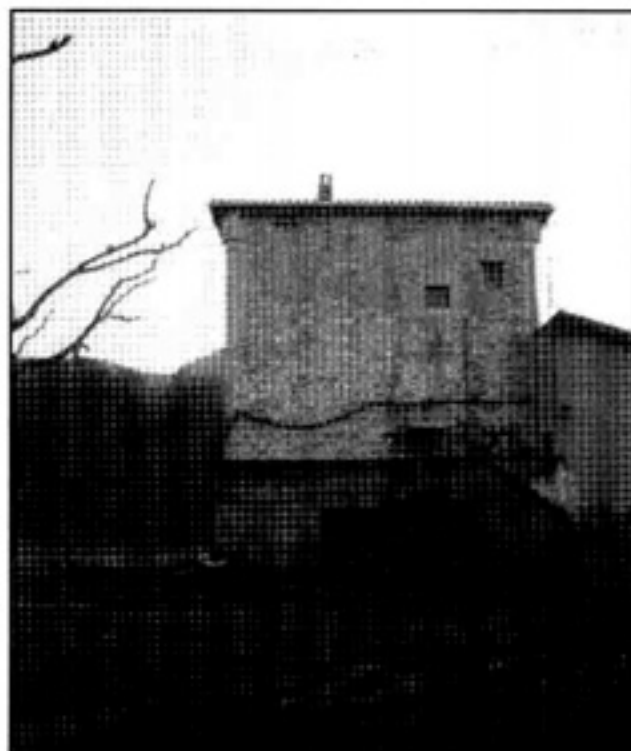
Casa Torre de los Orue o Guinea.
