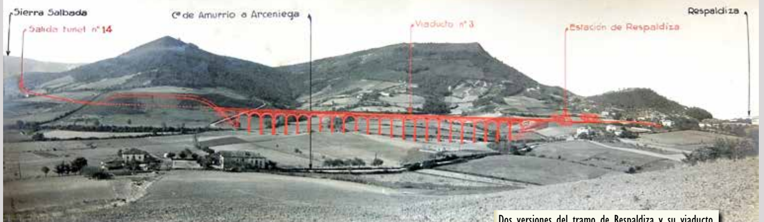
Dos versiones del tramo de Respaldiza y su viaducto
