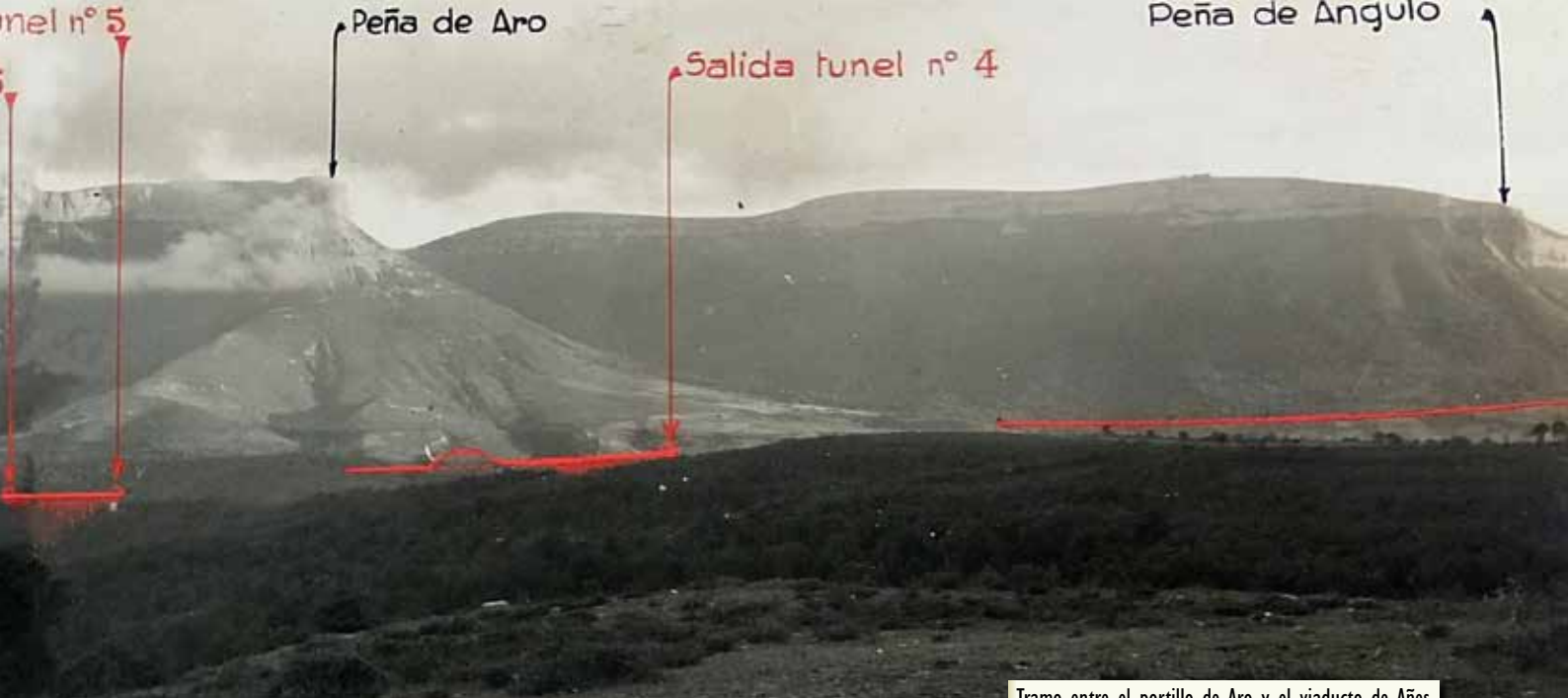
Tramo entre el portillo de Aro y el viaducto de Añes.
