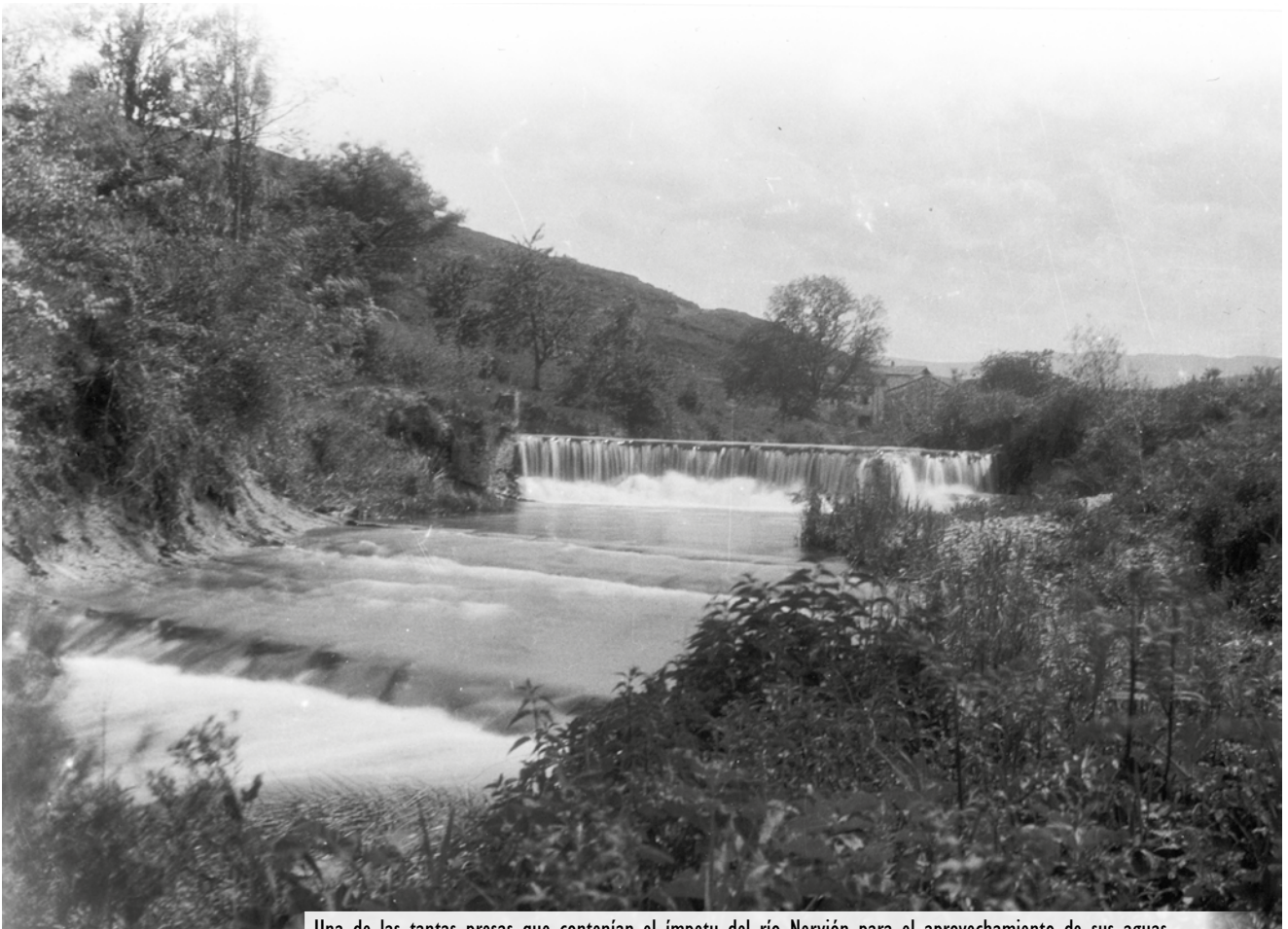
Una de las tantas presas que contenían el ímpetu del río Nervión para el aprovechamiento de sus aguas
