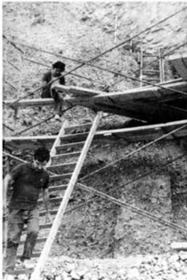
Las excavaciones se llevan a cabo en una franja vertical de 2 metros de longitud.
