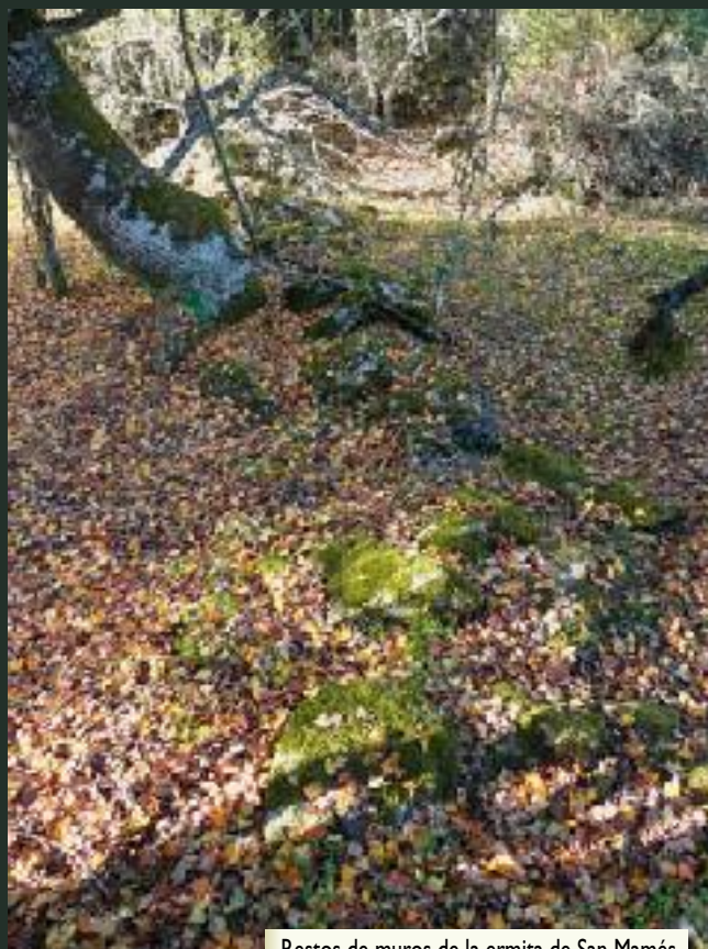
Restos de muros de la ermita de San Mamés
