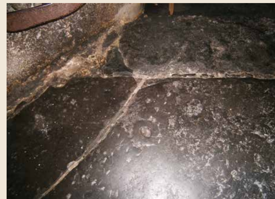
Agujero enmarcado, hecho en la losa de piedra, a la entrada porticada de la iglesia de Santa María de Amurrio
