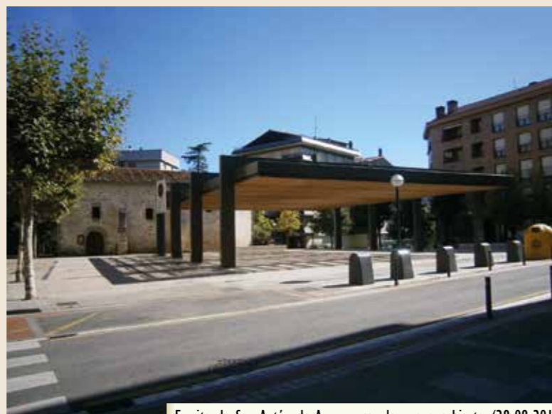
Ermita de San Antón de Armuru con la nueva cubierta. (28-08-2015)
