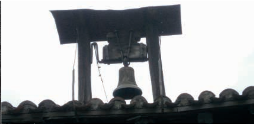
La esquila, antes de la restauración, asentada en su lugar de costumbre, con el paso del tiempo haciendo mella en su estructura. (10-02-2013)
