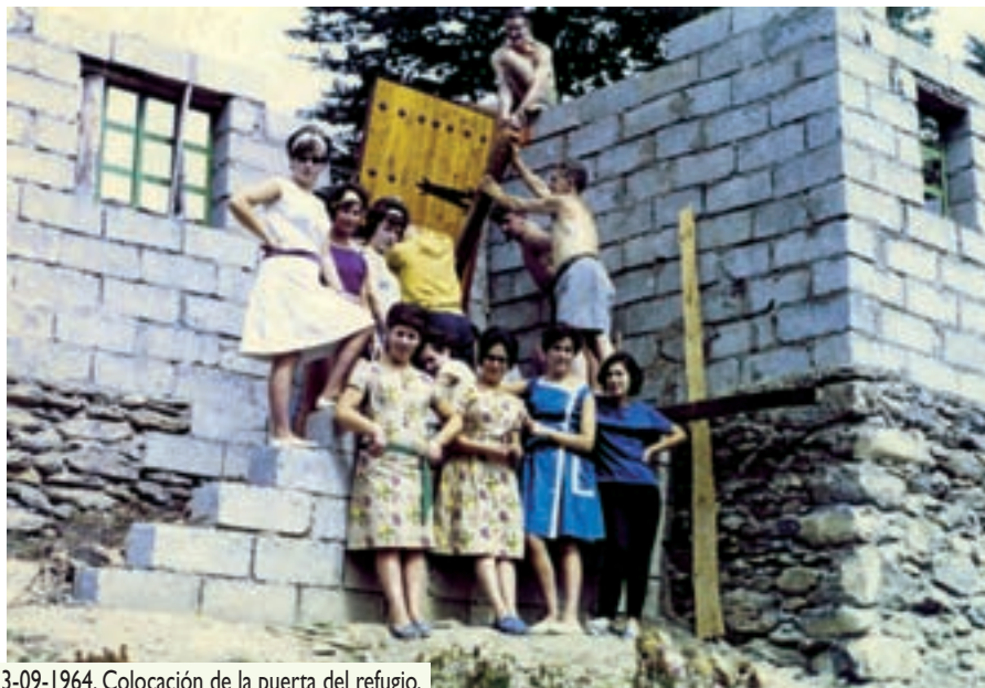
13-09-1964. Colocación de la puerta del refugio.
