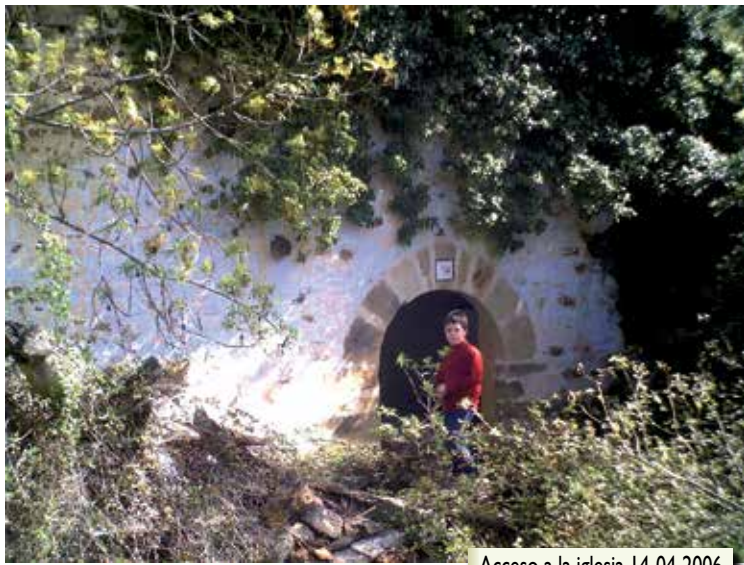
Acceso a la iglesia 14-04-2006
