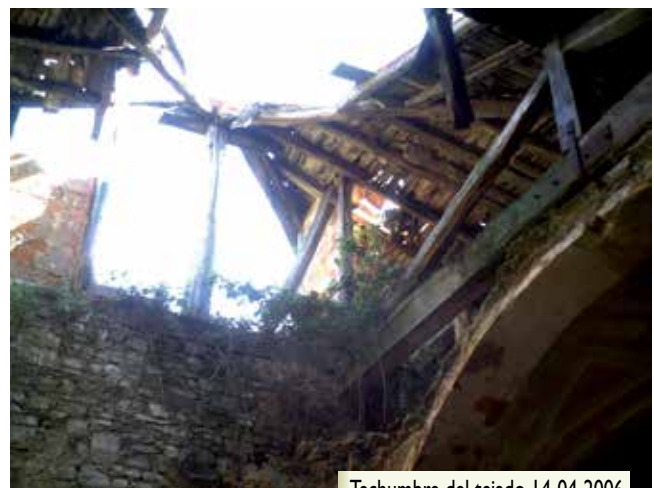
Techumbre del tejado 14-04-2006
