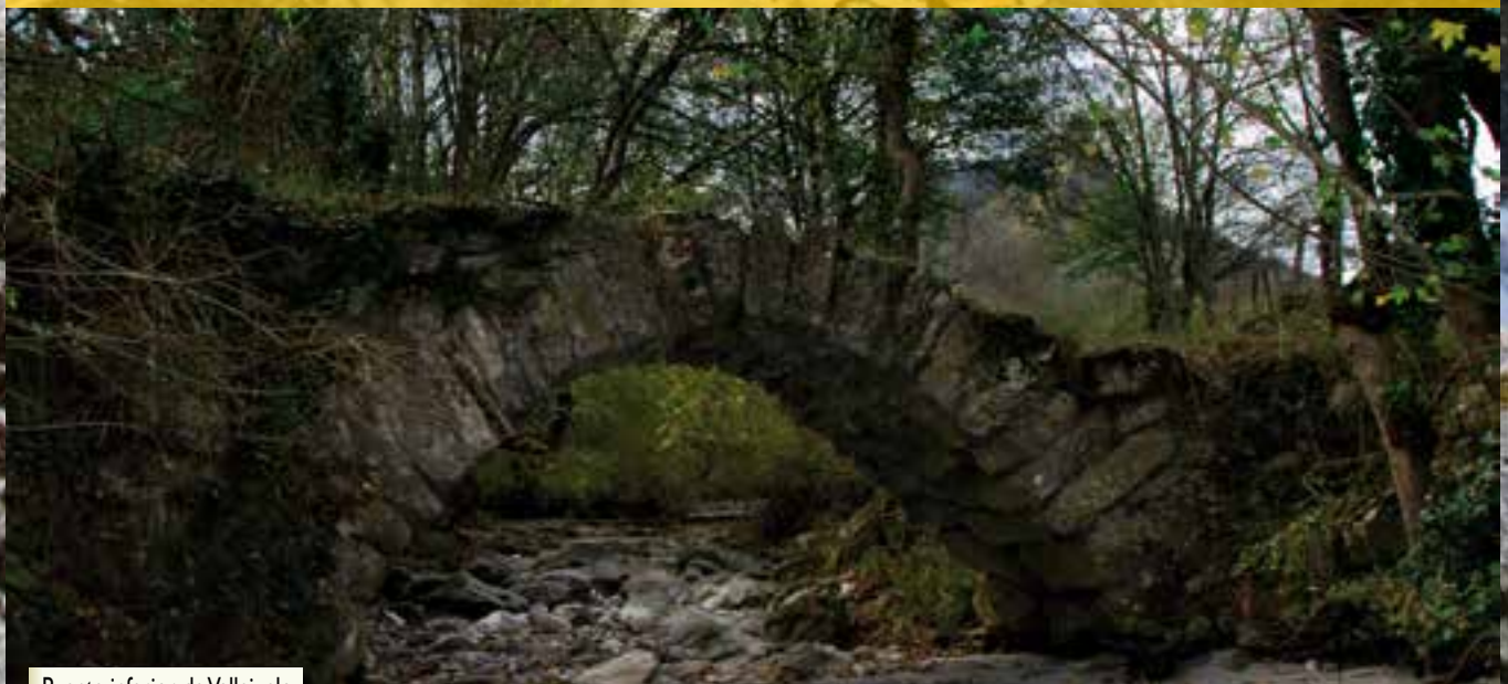
Puente inferior de Vallejuelo
