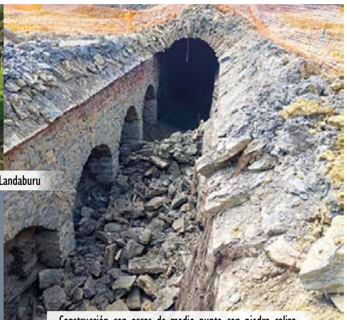
Construcción con arcos de medio punto con piedra caliza
