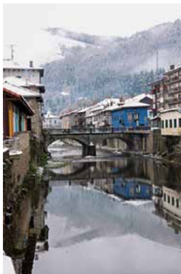
Puente de Zubiaur, conexión de la red transversal de caminos, que desciende de Ibarra, con el Camino Real, que en paralelo al Río Altube, enlaza Bilbao y Gasteiz. Foto: Ayuntamiento de Orozko.
